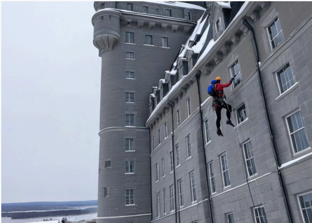
Descente en rappel sure le Fairmont le Château Frontenac
